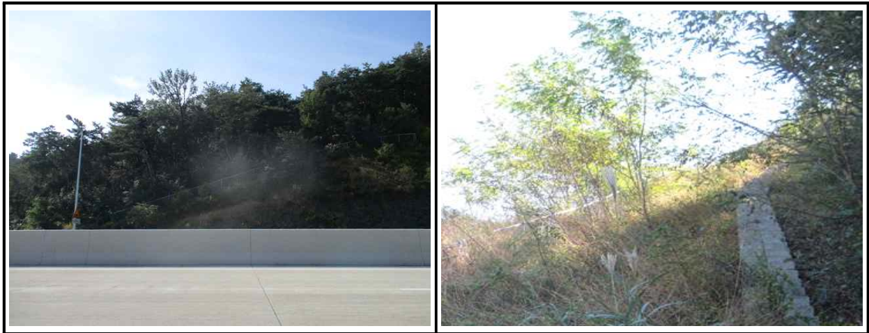
【그림 62.3.1】 상부자연사면 전경
