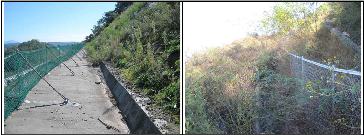
【그림 62.3.3】 배수시설 전경
